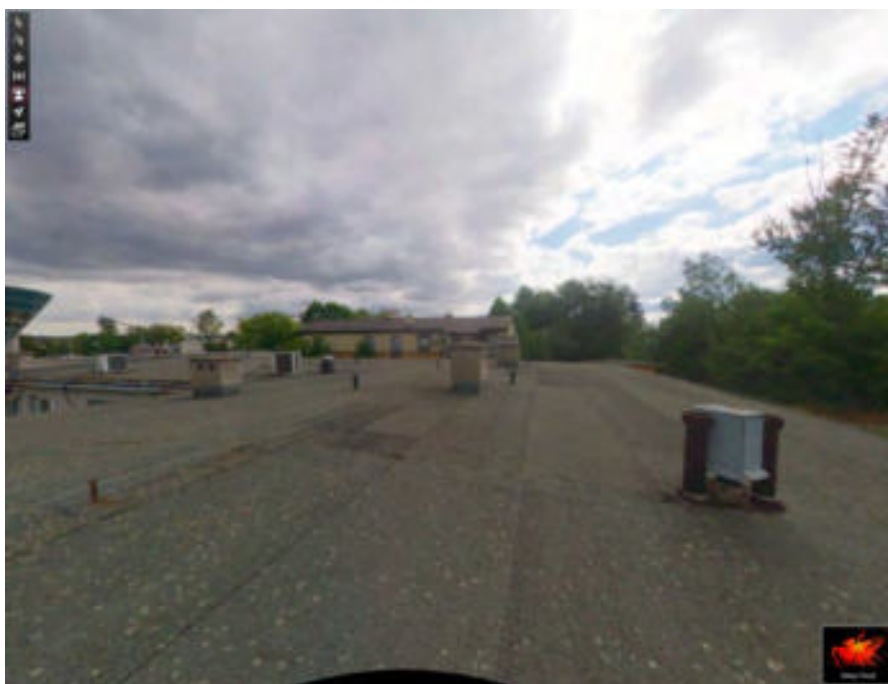
Widoki / zdjęcia połaci, na której jest planowany montaż instalacji PV
